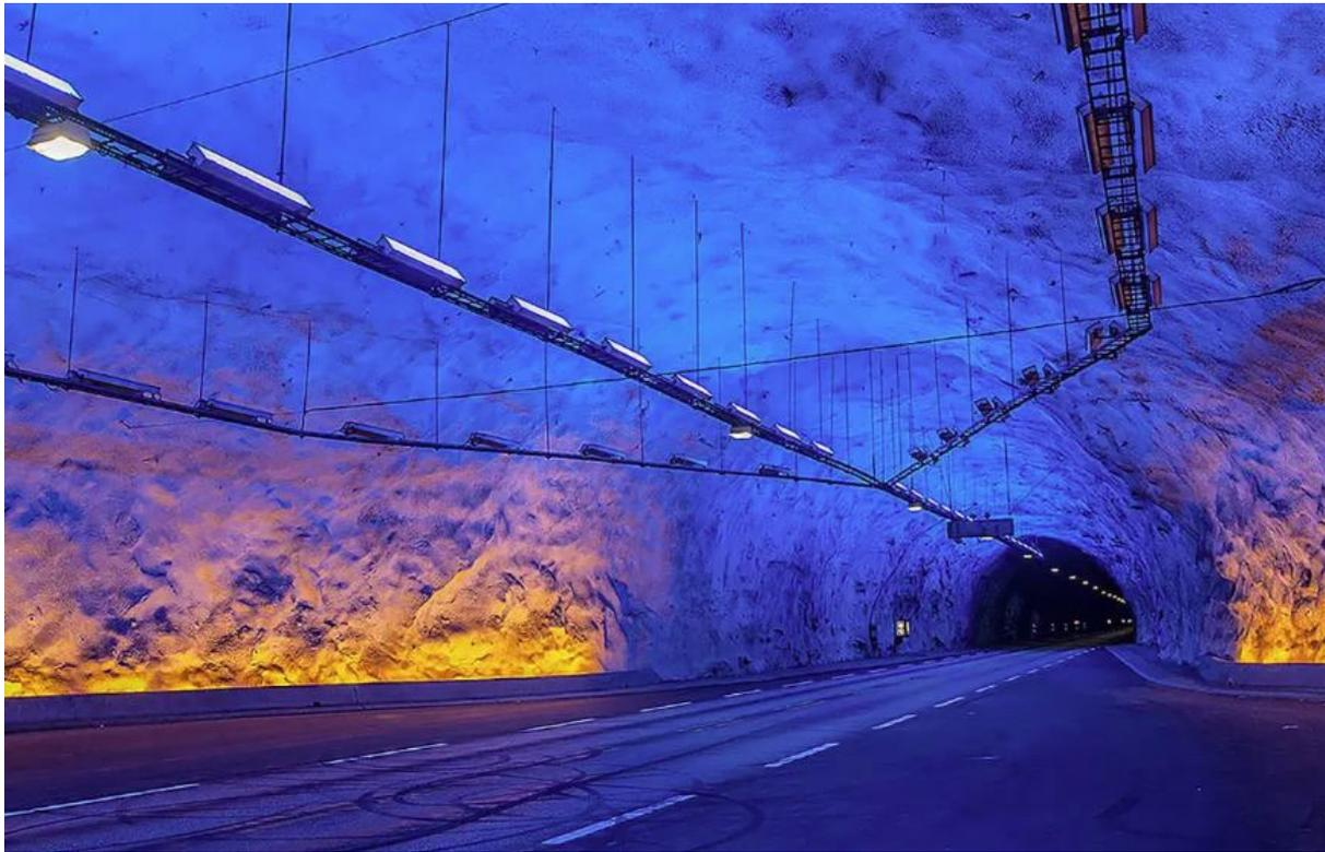
Figure 8-22 : Exemple d'infrastructure dans un tunnel routier comprenant la distribution d'électricité, l'éclairage et les communications via des systèmes coaxiaux rayonnants<sup>41</sup>
