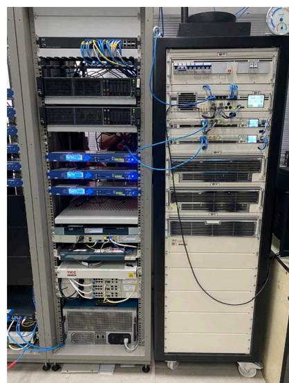
Figure 5-2 : Exemple de système de démonstration DAB+ à forte puissance
